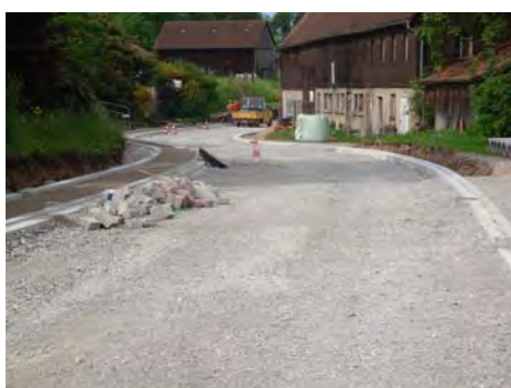
Eingebaute Schottertragschicht und neue Fahrbahnberandung:
