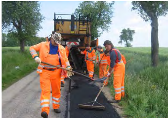
Asphalteinbau per Hand
