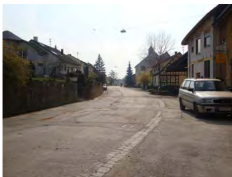
Bisherige Situation: Viele Schadstellen, keine Oberflächenentwässerung, fehlende Berandung.
