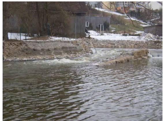
nach Umbau in eine Raue Rampe
