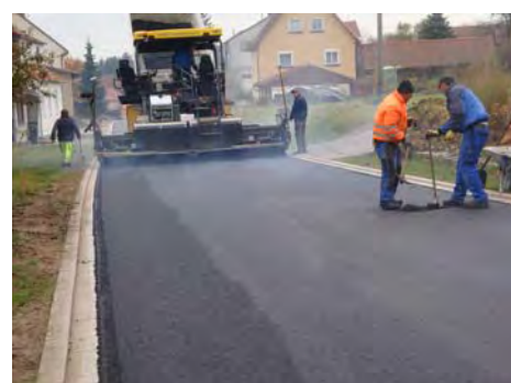
Einbau der Asphaltsschichten:
