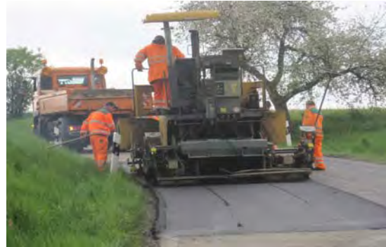
Asphalteinbau mit Fertiger
