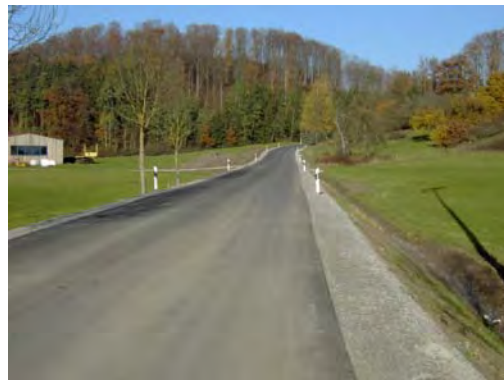
Neue Fahrbahn mit Bankette:
