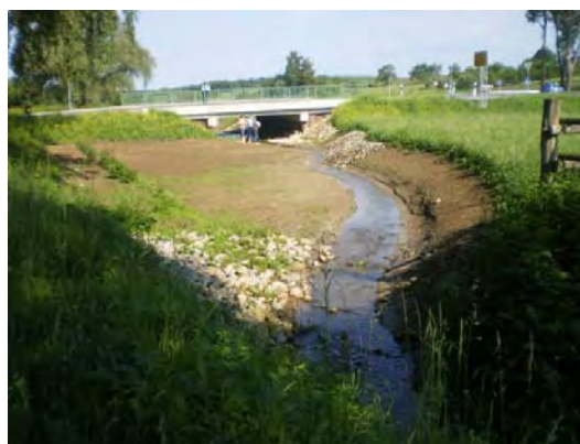
Rot am See – Brettheim Neubau Brettachbrücke bei Verlegung L 1040
