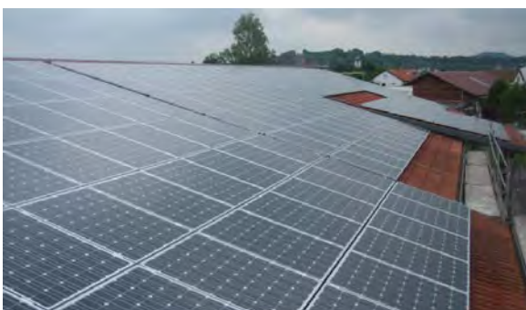
Das Dach des Kindergartens Bühlertann hat ebenfalls eine WFG-Anlage erhalten.
