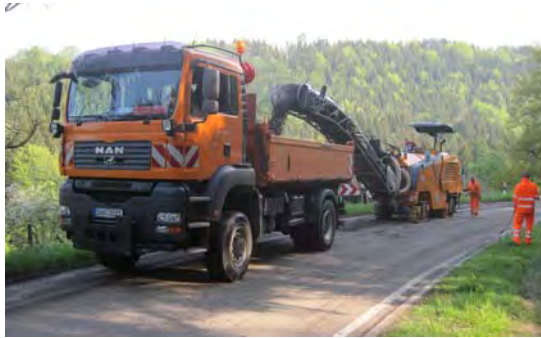
Einsatz mit Asphaltfräse
