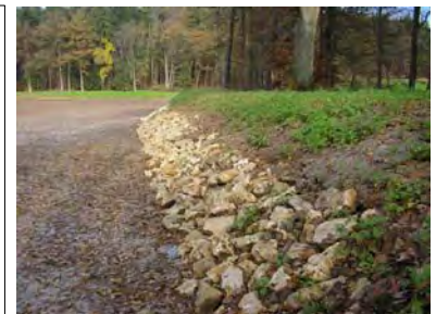
Steinsicherung eines Weiherdamms
