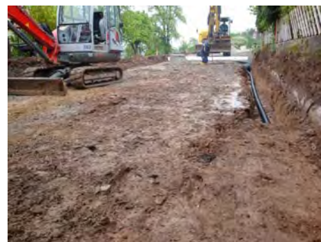
Umfassende Erdarbeiten, um einen tragfähigen Untergrund herzustellen:
