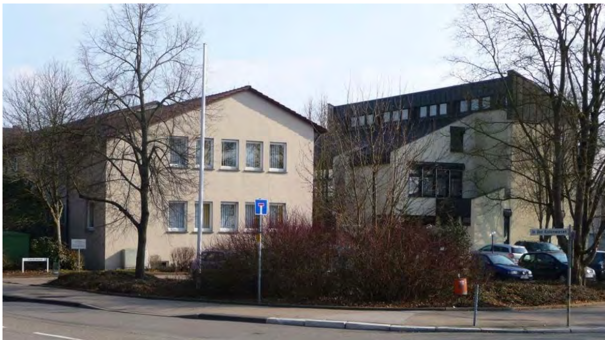
Vermessungsamt – Neues Dienstgebäude In den Kistenwiesen 2/1 in Crailsheim
