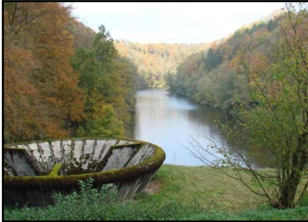
Hochwasserrückhaltebecken Beimbach im Dauerstau
