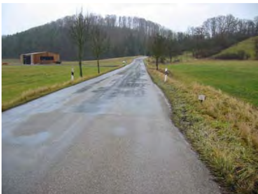
Blick von Herlebach Richtung Sulzdorf Alte Fahrbahn:
