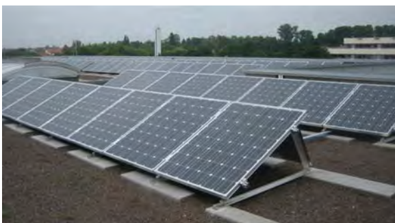
Im Jahr 2010 wurde z. B. das Flachdach der Kfm. Schule in Crailsheim im Rahmen der Dachsanierung mit einer PV-Anlage bestückt.
